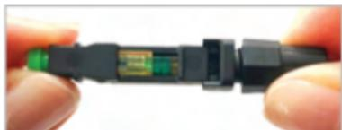
9. Đóng kẹp đuôi lại. Vặn chặt phần nắp xoắn vào phần thân đầu nối. Kiểm tra chắc rằng phần vỏ cáp cố định chắc chắn.
